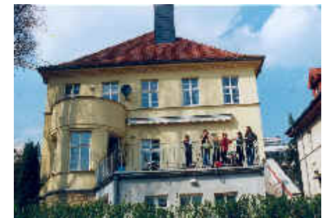
Beispiel: Elternhaus Halle (Saale) mit anstehender Renovierung der Terrasse
